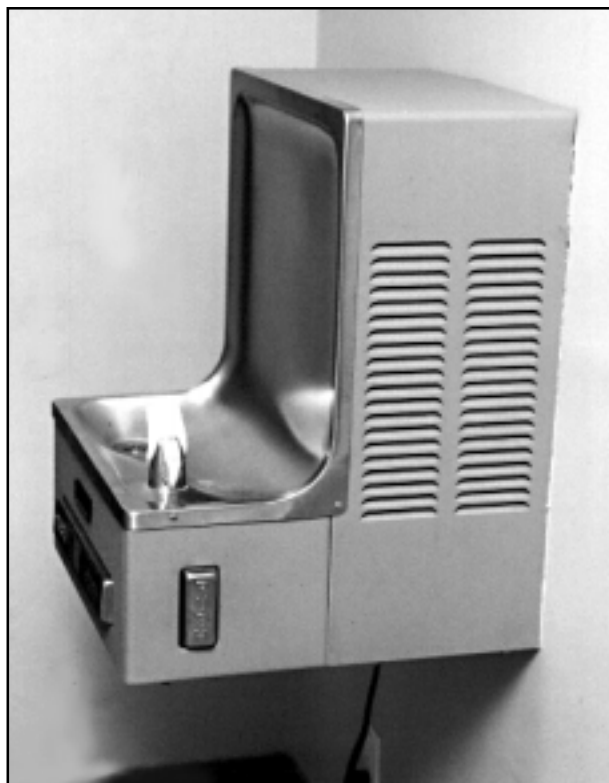
Une fontaine accessible doit être munie d'un contrôle sur le côté et à l'avant et ces contrôles doivent être du type plaque-poussoir ou à levier.
